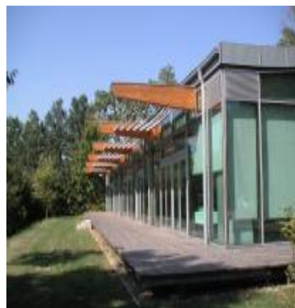
Längsansicht des Gebäudes
